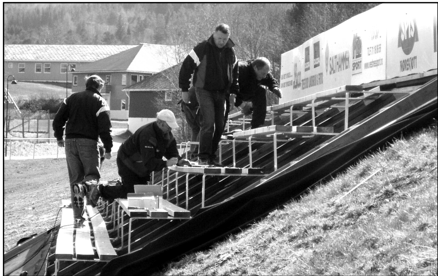
Dugnadsgjengen i ferd med å sette saman den nye tribuna . (foto: kaims)
